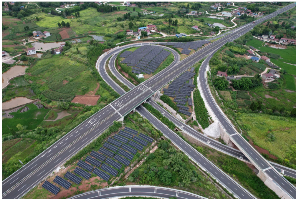
7月2日,在内江市绕城高速公路上,一排排光伏板通过吸收太阳能并转化为绿电,为高速公路运行提供能源供给。
